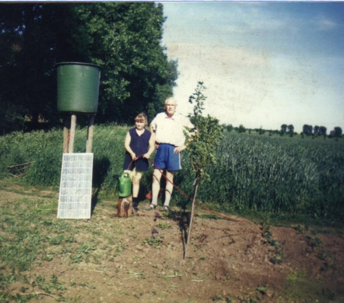
Gartenbewässerung mit solarbetriebener Pumpe
